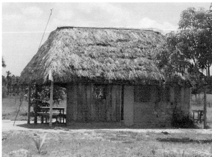
Fotografia 5 - Moradia de palha e alvenaria.
