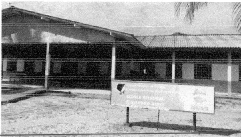
Fotografia 12 - Fachada da Escola Estadual Sizenando Diniz.
